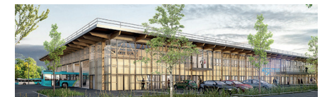
Dépôt des bus des transports urbains, Saint-Brieuc, France Architecte: DLW Architectes © DLW Architectes
