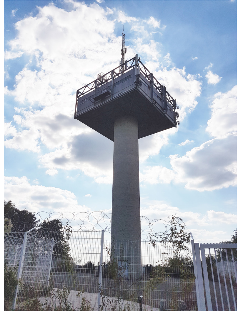
La Tour France Telecom, un repère dans le paysage
