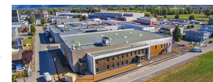
Legumerie et pôle alimentaire Lezsaïsons, Saint-Pierre-en-Faucigny, France. © Burdet
