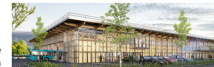
Dépôt des bus des transports urbains, Saint-Brieuc, France Architecte: DLW Architectes © DLW Architectes
