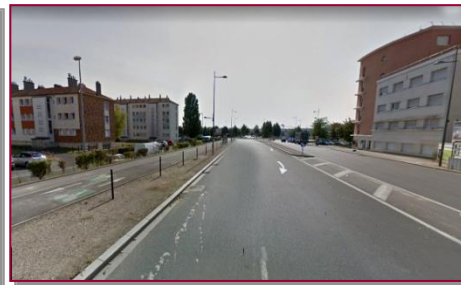
La RD19, un gabarit de voie très large
