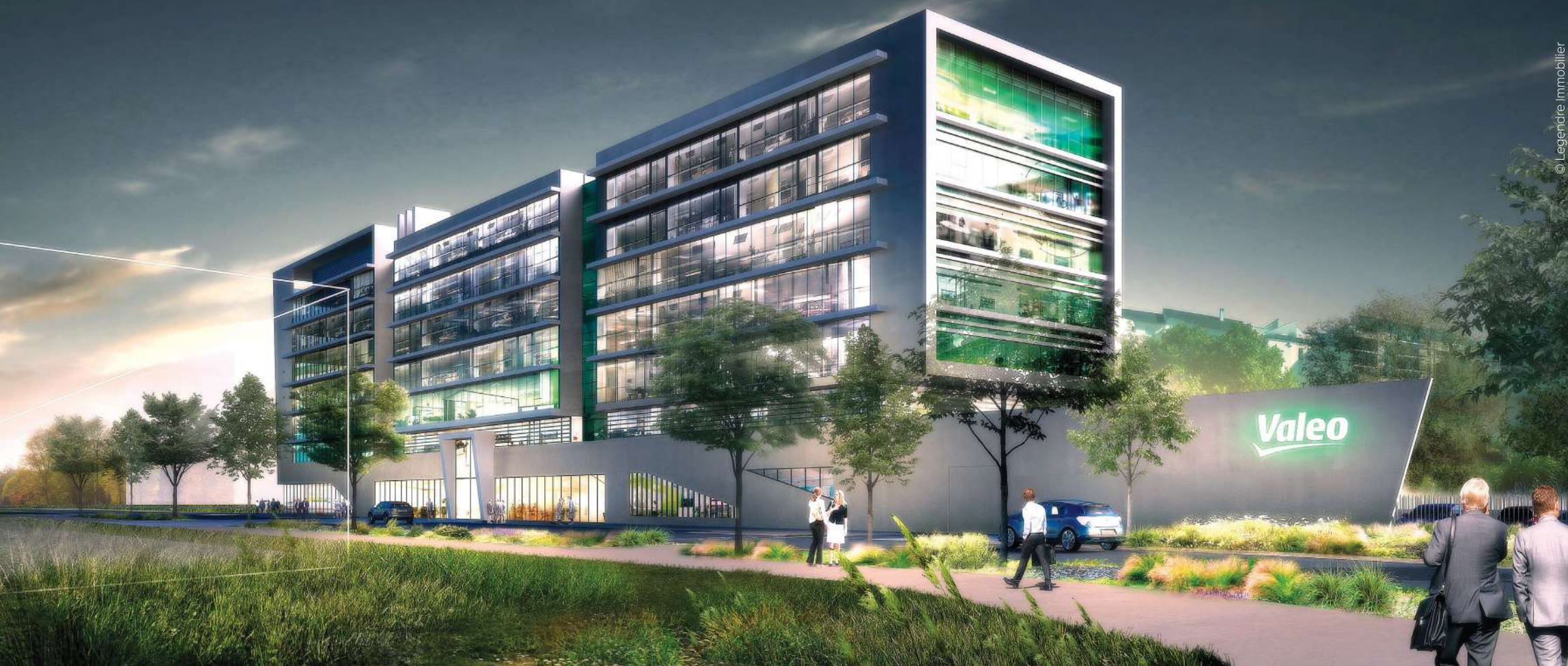
▲ Futur centre de recherche de l'équipementier automobile Valeo à la Pointe du Lac (Créteil).
