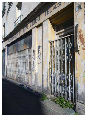
Un ancien commerce actuellement vacant - 22 rue de Seine - SCURE 2015
