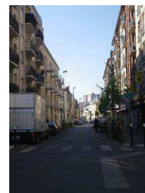
Rue Véron (axe important) : immeubles à R+4
