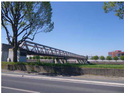
La passerelle GRT
