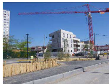
Opération ANRU à Chantereine : requalification de l'espace public
