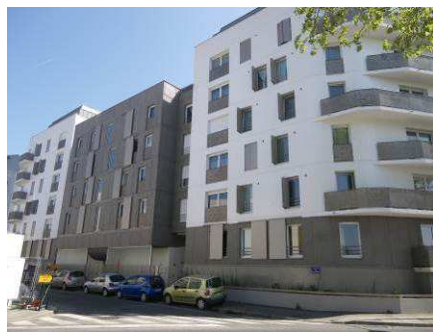
Quai Blanqui : constructions récentes à R+5
