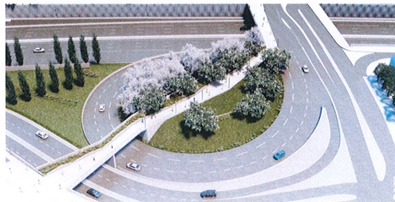
Future passerelle du pont de Nogent.
