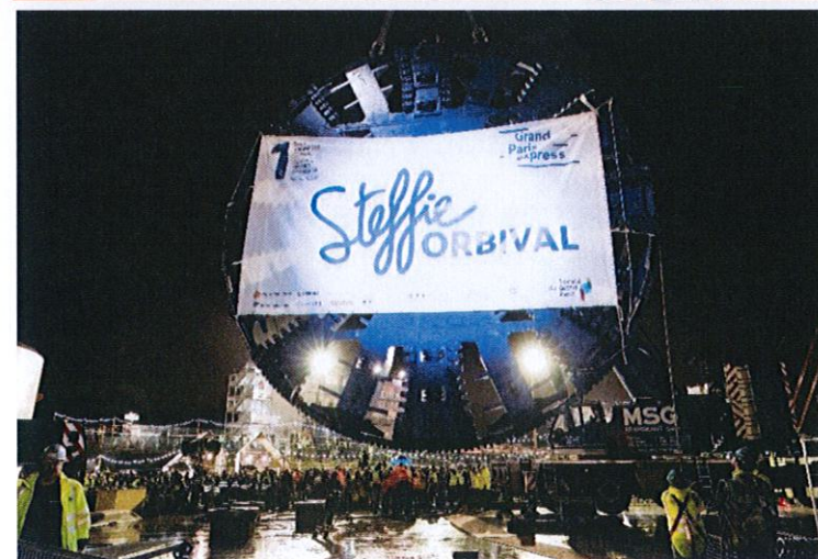
1 er tunnelier du Grand Paris Express, Steffie-Orbival est arrivée au parc départemental du Plateau à Champigny-sur-Marne le 3 février 2018.
