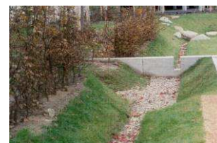
Noue intégrée au bâti
