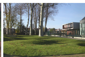
Espace paysager intégrant un bassin de rétention
