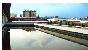
Toitures terrasses réservoirs
