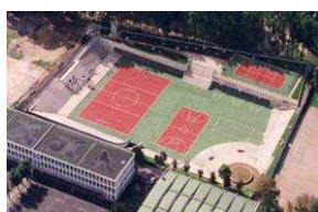
Terrain de sport aménagé en zone inondable
