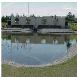
Bassin à ciel ouvert en eau
