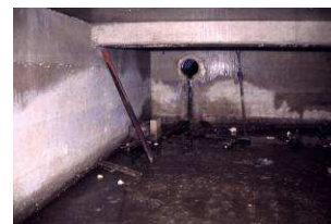
Ouvrage de stockage enterré
