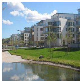
Bassin à ciel ouvert en eau
