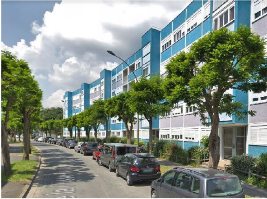
Une façade rythmée matérialisant les entrées
