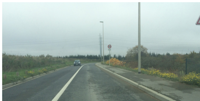
La RD110 (source HDarchitectes, 2016)
