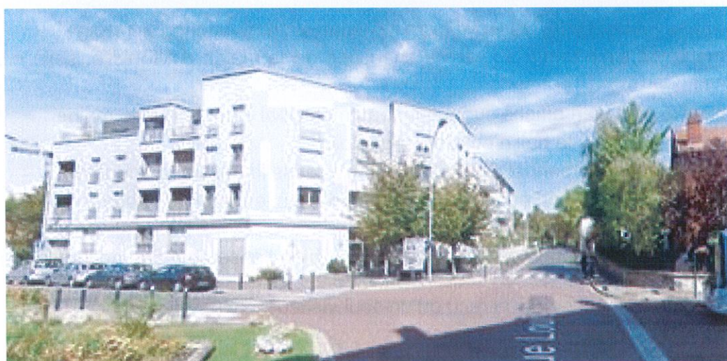
Vue de l'Opération rue Louis Blanc terminée
