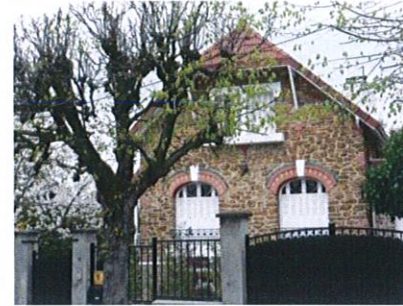
11 rue Albert Pleuvry
