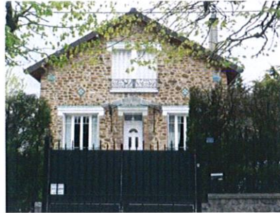
9 rue Albert Pleuvry
