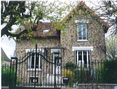
7 rue Albert Pleuvry
