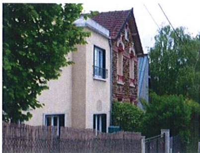
7 rue des Bouiards
