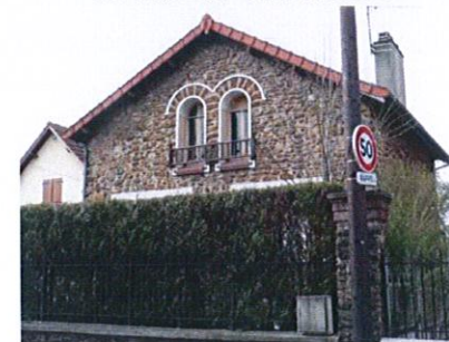
72 rue de Villeneuve
