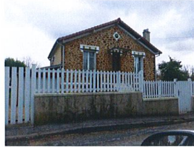
15 rue des Bouiards
