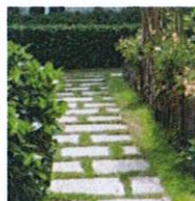
Pavés à joints enherbés
