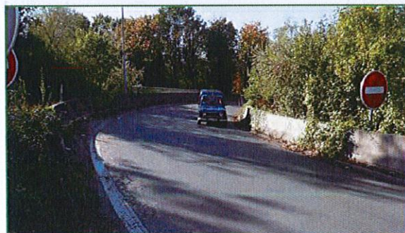
10 - Les bretelles autoroutières s'insèrent dans ce milieu végétal
