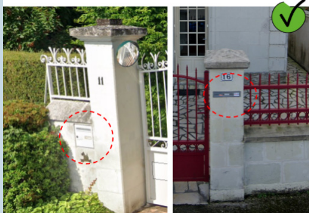
Intégrée dans la maçonnerie
