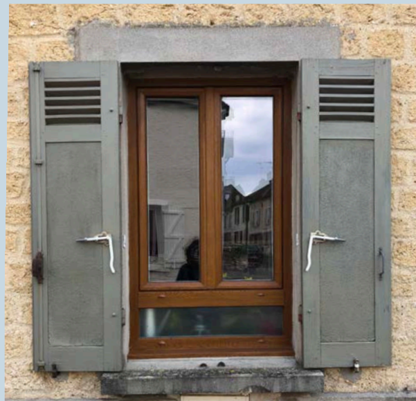
Persiennes en partie haute au rez-de-chaussée
