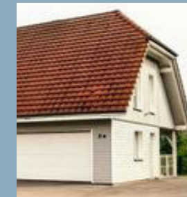
Type de toit et volumétrie disproportionnés et inadaptés aux styles du bâti à Santeny
