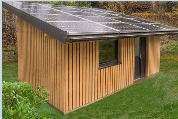
Exemple de toiture solaire de cabanon de jardin: les panneaux sont encastrés et remplacent la couverture du toit. Ils forment ainsi un ensemble harmonieux.
