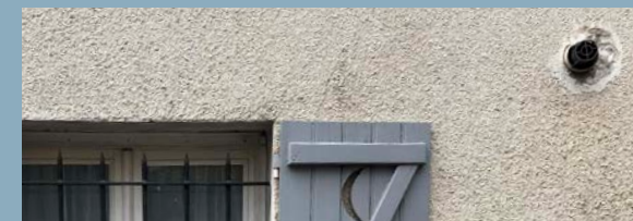
Les sorties des ventouses doivent être situées côté arrière et leur traitement doit être soigné. Leur couleur doit être de teinte similaire à celle de la façade.
