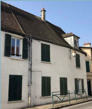
Toiture à tuiles plates au centre-ville ancien.
