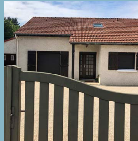
Toiture à tuiles mécaniques secteur Nord-Ouest.
