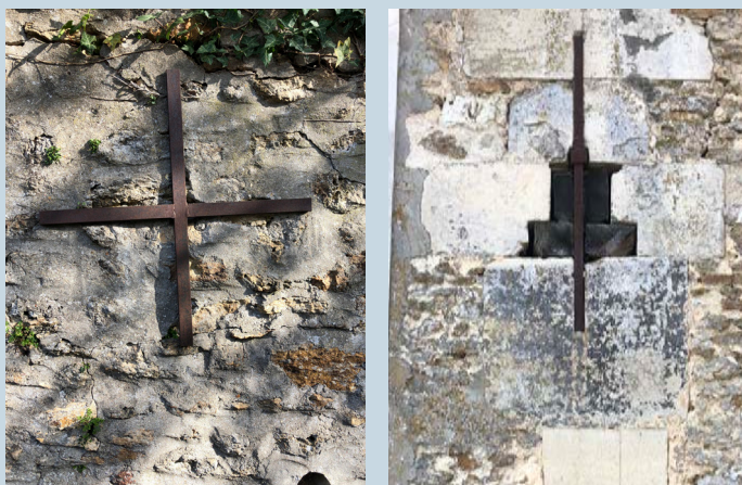
Ancre et tirant empêchent l'écartement des façades.
