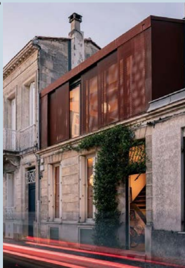
Surélévation - FELAA ARCHITECTES
