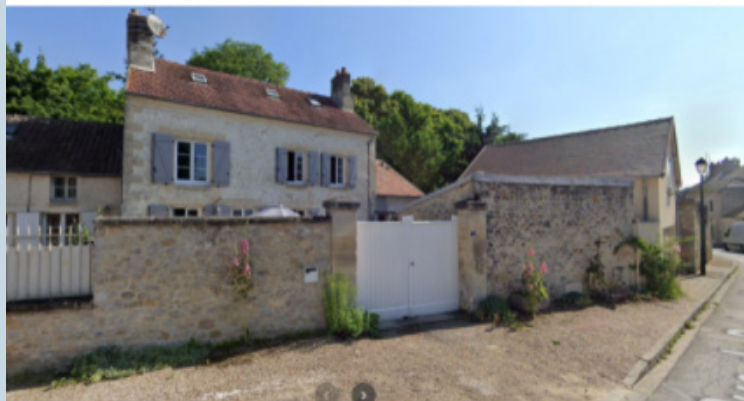
Désimperméabilisation et végétalisation des trottoirs et des murs à Avilly-Saint-Léonard (Oise) (entretien par les habitants) source : Google Maps
