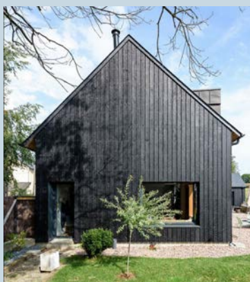
Extension bois bardage brûlé Architectes Briand-Renault
