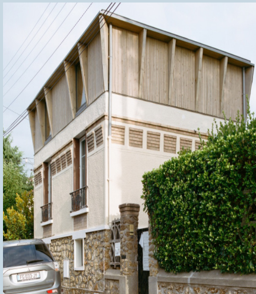
Surélévation d'une maison meulière, Benoît Rotteleur Architecte
