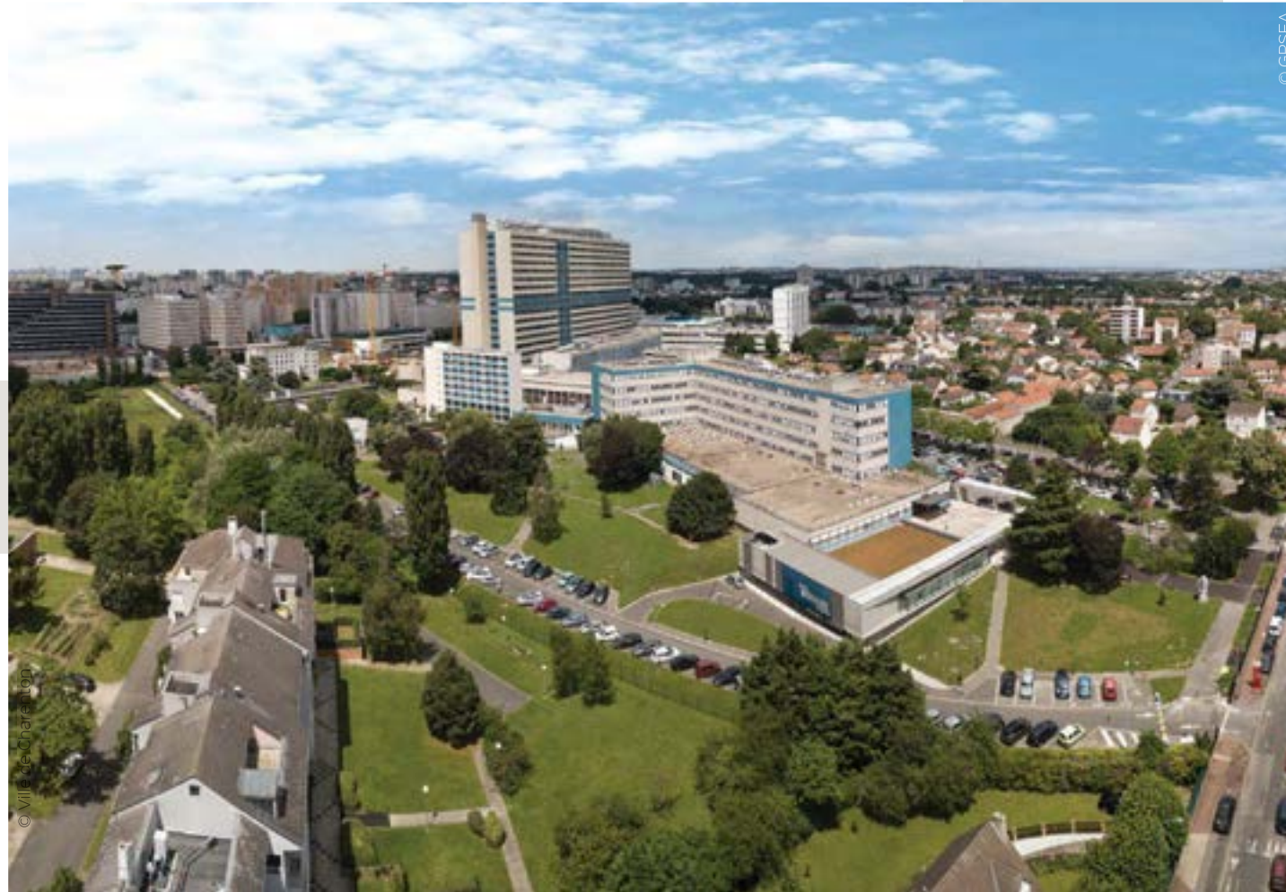
▲ Vue du centre hospitalier universitaire Henri-Mondor à Créteil.
