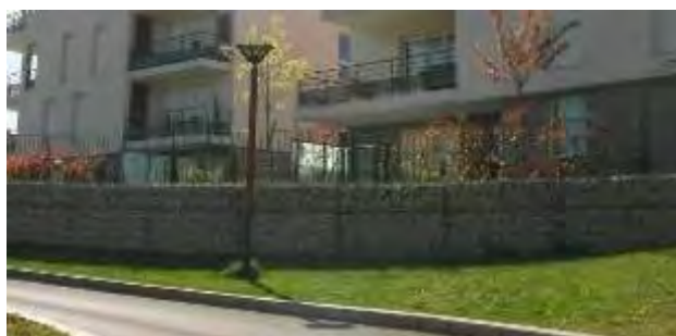
Figure 165 : Exemple de murets en gabions contre un espace vert
