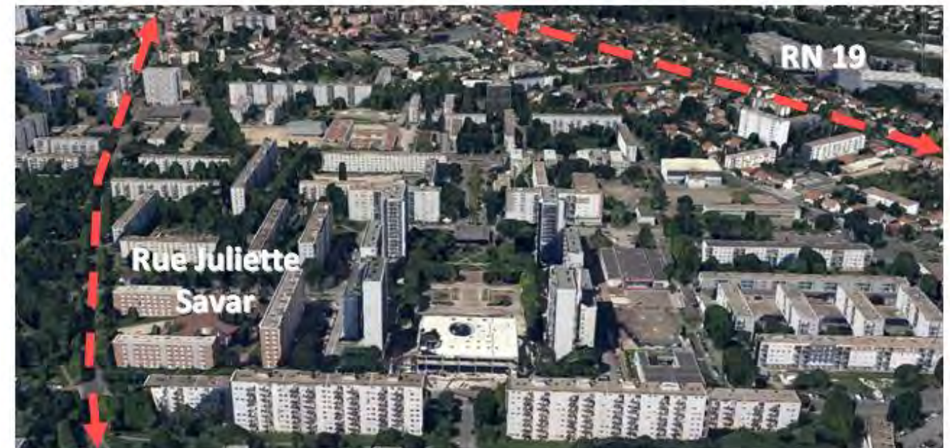
Vue aérienne du quartier du Haut Mont-Mesly
