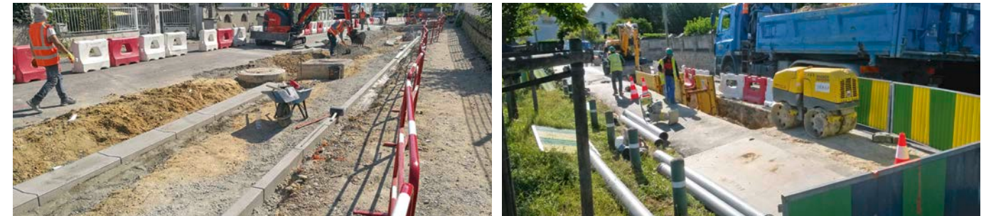
Travaux voirie Villecresnes Travaux assainissement Boissy-Saint-Léger
