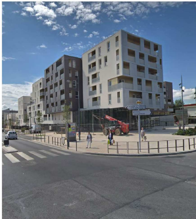
Habitat collectif récent hauts à Bonneuil-sur-Marne
