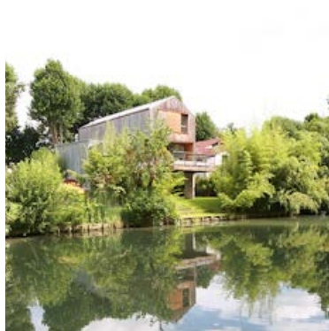
7. Bords de Marnes de Créteil
