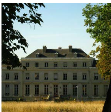
4. Hôpital Émile Roux, Limeil-Brevannes
