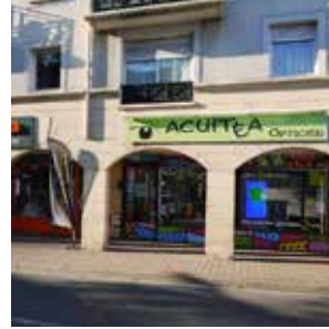
Enseignes mal intégrées au bâti
