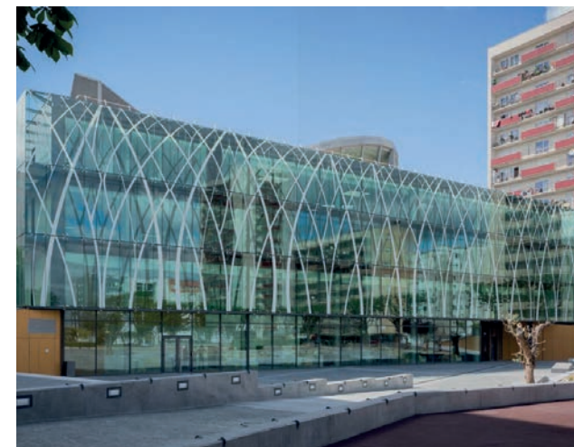
Médiathèque Nelson Mandela
