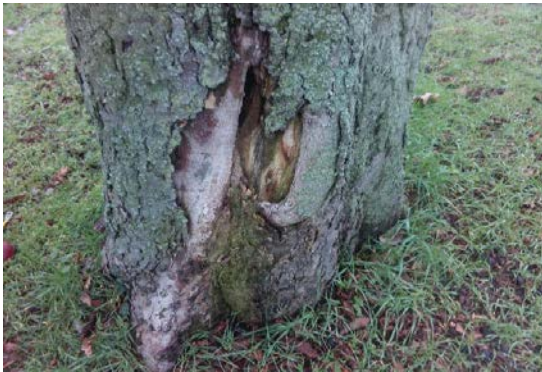
< Photo d'un défaut relevé ou détail sur sujet
