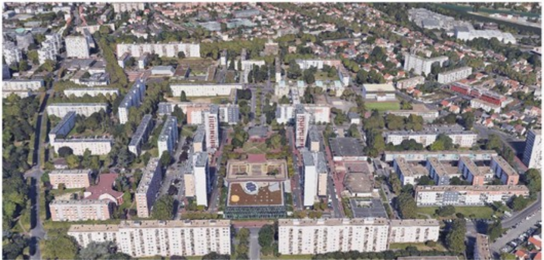
Vue aérienne du site du projet du Haut du Mont Mesly (EI, première de couverture) (vue vers le nord, avec au premier plan la médiathèque et la place de l'Abbaye)
