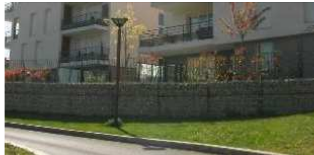
Figure 197 : Exemple de murets en gabions contre un espace vert
