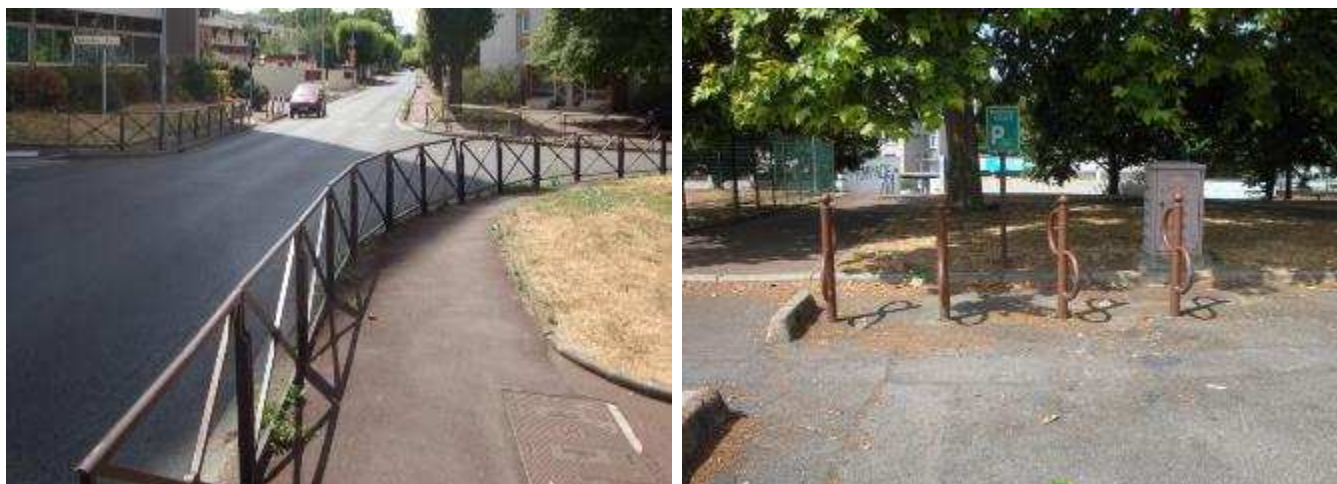
Trottoirs et stationnements deux roues, rue Juliette Savar
