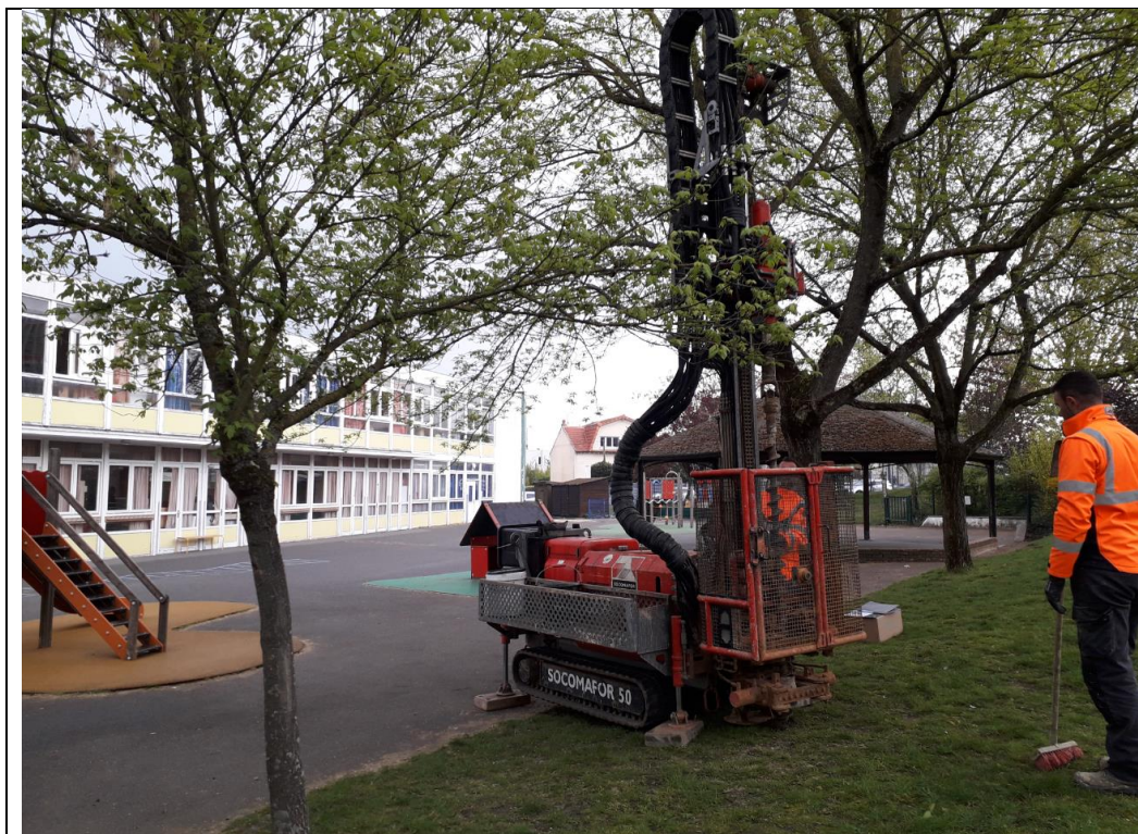
Vue sur le sondage S5
