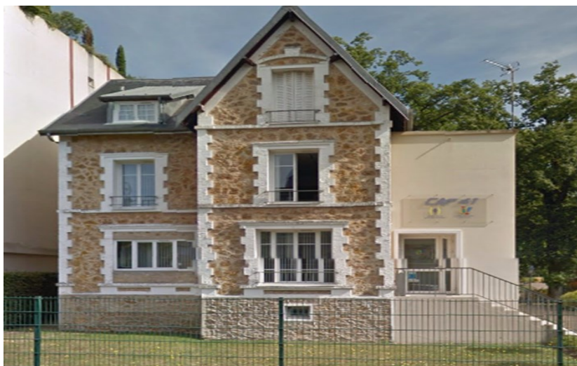
Figure 7 : Photographie de la façade de la Mission locale. Réalisée par Emmy Fickinger le 05/11/2021
