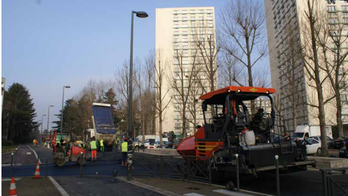
Travaux de voirie
