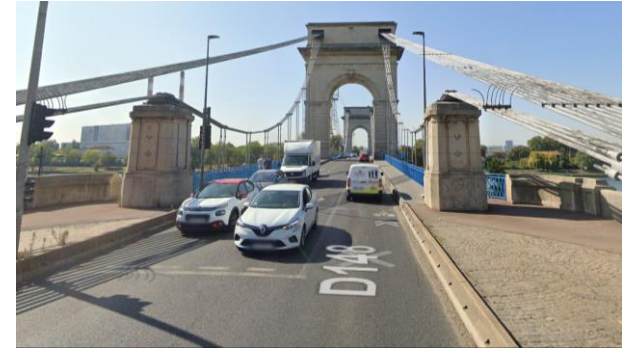
RD148 - Le Pont du Port à l'Anglais à Alfortville
