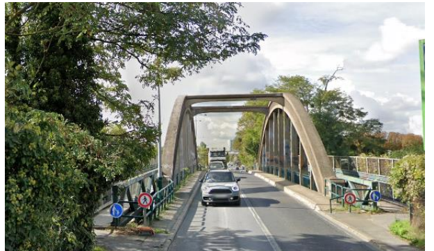
RD111 - Le Pont de Paris à Sucy-en-Brie
