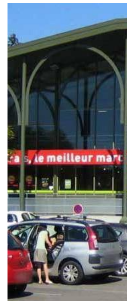
Façade type grande halle métallique
