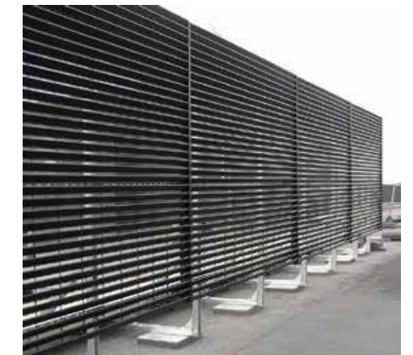
Toiture technique avec pare vue / paroi occultante
