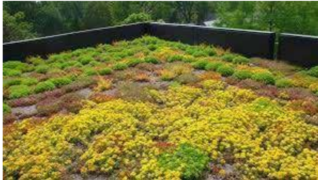
Toiture terrasse végétalisée soignée
