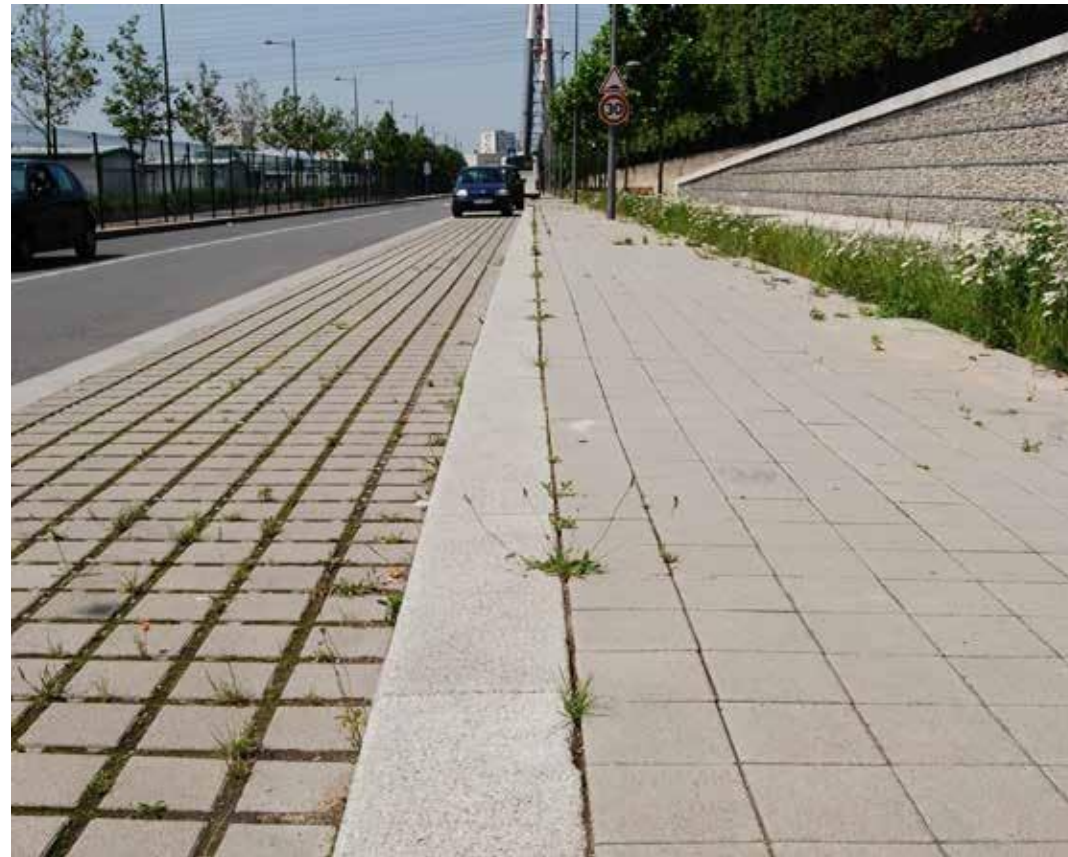
Pavé béton pour voie modes actifs et stationnement - Chevilly-Larue - Agence L'Anton
