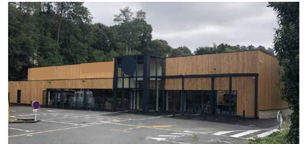
Façade Magasin d'entrée de ville utilisant des matériaux naturels : Exp. en bois
