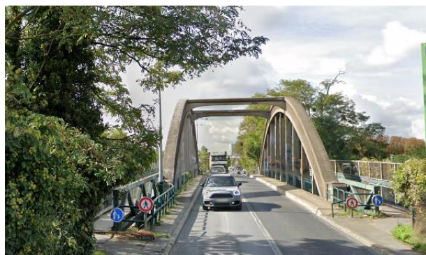
RD111 - Le Pont de Paris à Sucy-en-Brie
