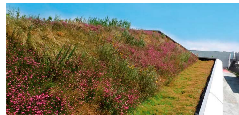
Toiture végétalisée à forte pente
