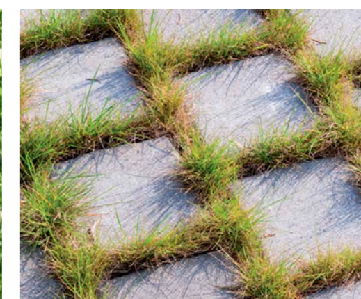
Pavés à joints végétalisés
