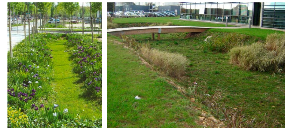
Noues et bassin
