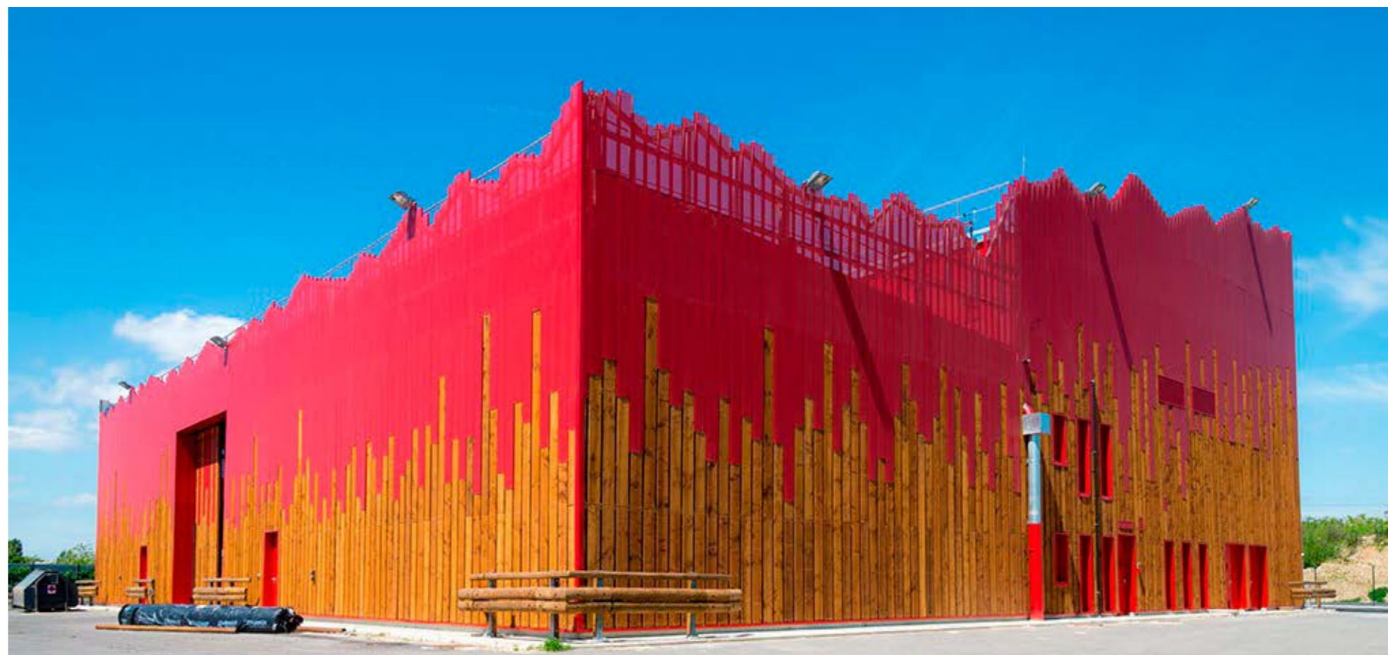
Centrale Biomasse de Limeil-Brevannes.
