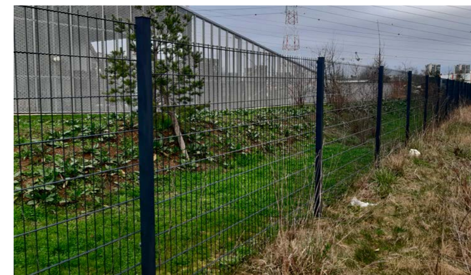
Clôture treillis soudés: Type Nylofor 2D à poteaux carrés de chez Bétafence ou équivalent de couleur noire.
