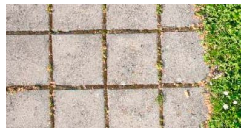
Pavés à joints perméables (gravier)
