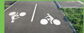
voie réservée aux cycles, séparée physiquement de la chaussée
