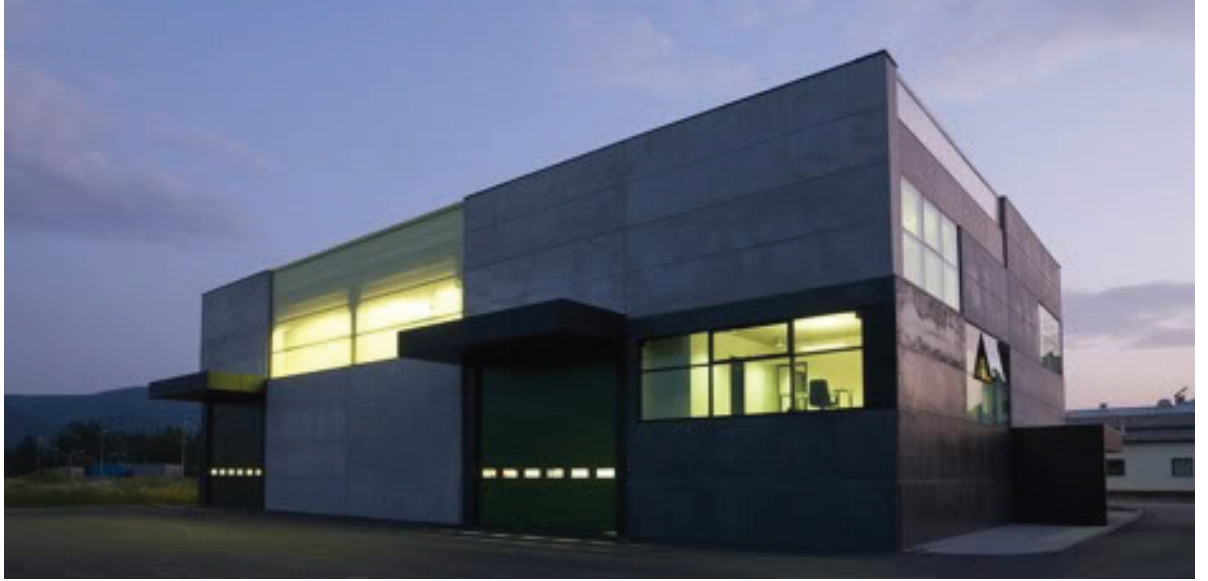
Entrepôt créatif dans un container de béton. Ofis Arhitekti
