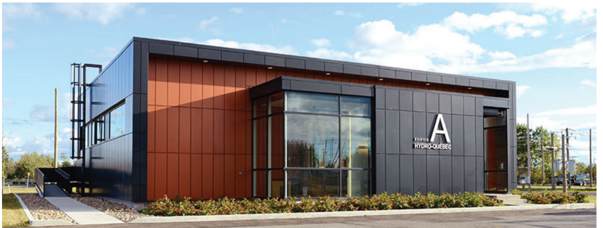
Bâtiment industriel -Rivières-Québec
