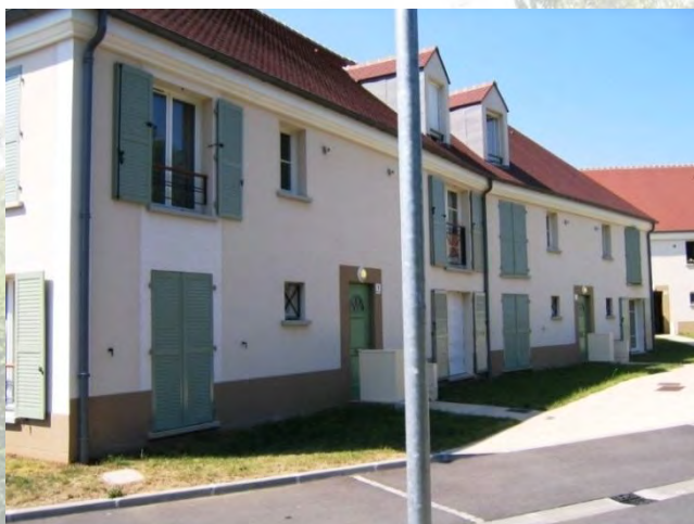
Logements sociaux de Valophis rue Pierre Bezançon
