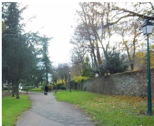
Mur situé à proximité du centre commercial (voie aux vaches)
