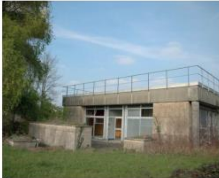
Bâtiment abandonné dans l'enceinte de France Telecom
