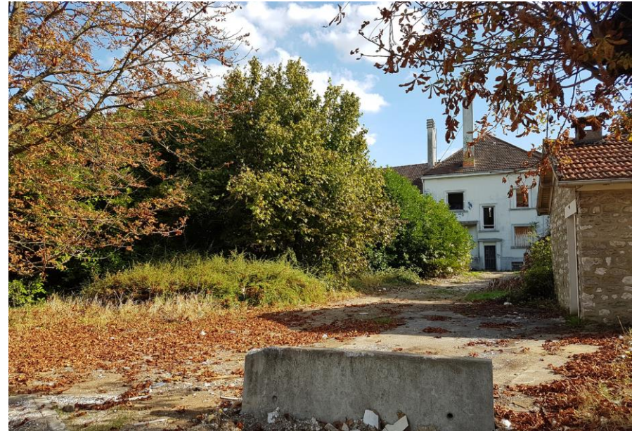
Figure 2 : Photographie de la friche France Telecom (source : AME 2018)
