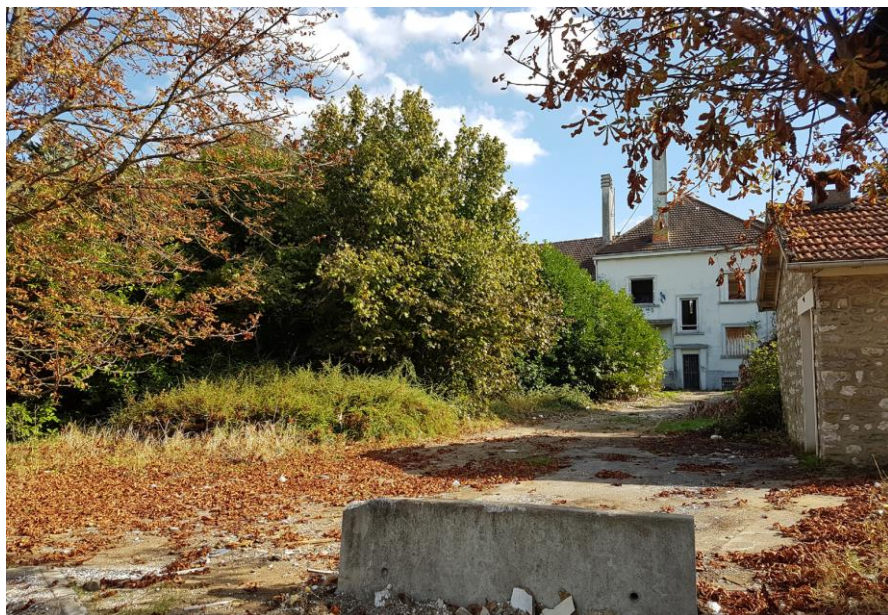
Figure 16 : Photographie de la friche France Telecom (source : AME 2018)
