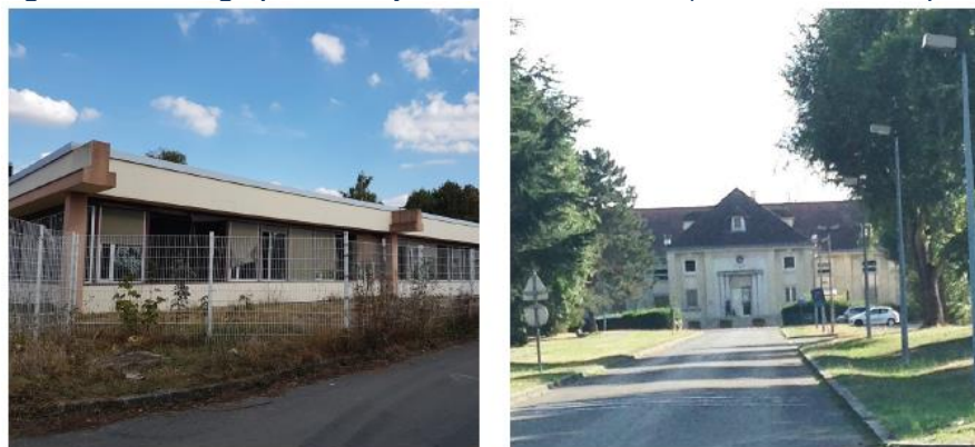
Figure 17 : Photographie du data center et du « Château » -(source : AME 2018)
