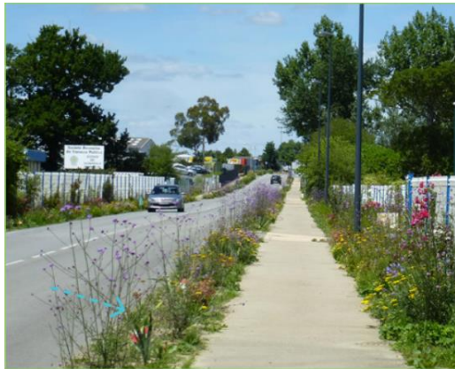
▲ Bordure végétale | récupère les eaux de la chaussée
