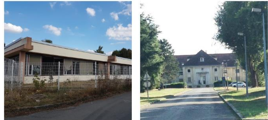
Figure 3 : Photographie du data center et du « Château » -(source : AME 2018)
