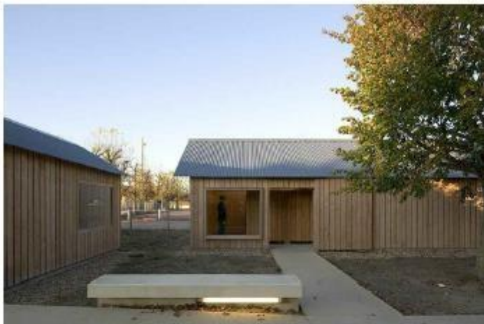
Bardage bois / Toiture bac acier
