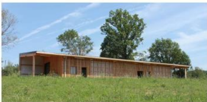
Bâtiment de maraîchage à Neuilse (42).
