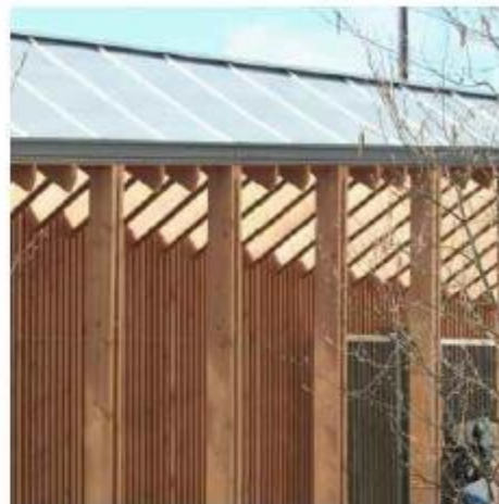
Bardage bois / Toiture bac acier
