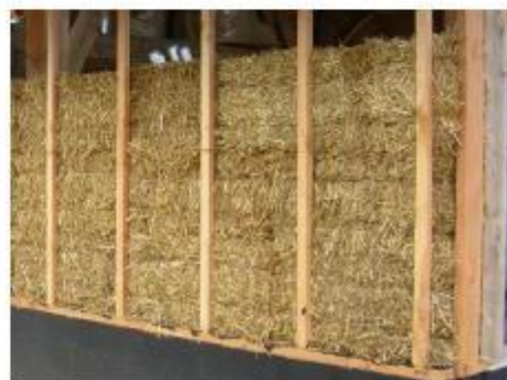
Isolation paille dans ossature bois
