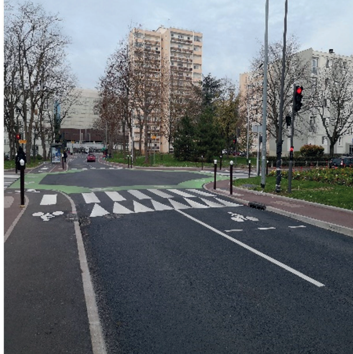
Travaux de voirie Rue Casalis à Créteil
