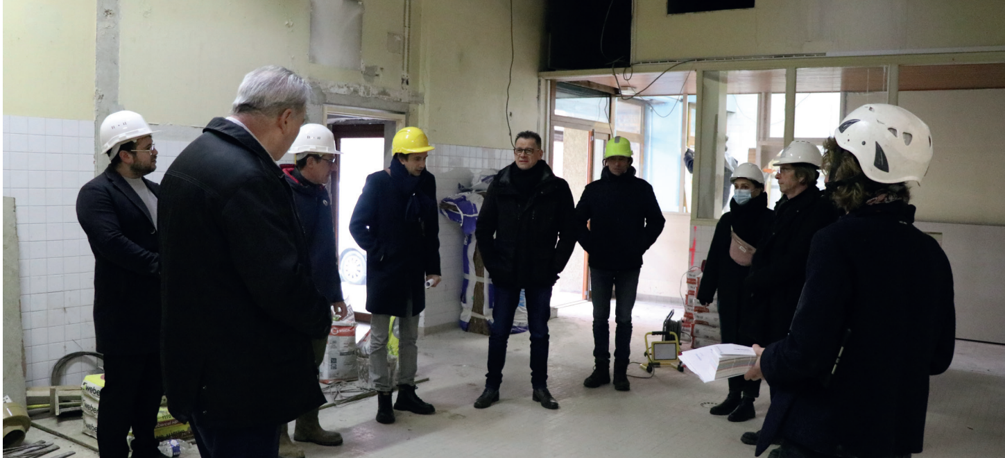
Visite de chantier de la recyclerie à Boissy-Saint-Léger
