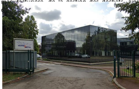
Entreprise Verre & Métal à Bonneuil-sur-Marne
