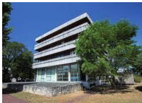
Bâtiment Descartes à Limeil-Brevannes. Source : GPSEA
