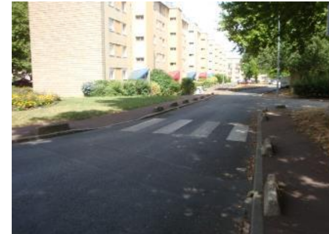
Traversée piétonne ne répondant pas aux normes PMR (Absence de bande podotactile)
