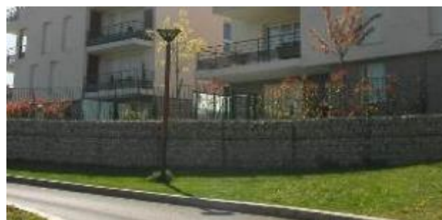
Figure 180 : Exemple de murets en gabions contre un espace vert
