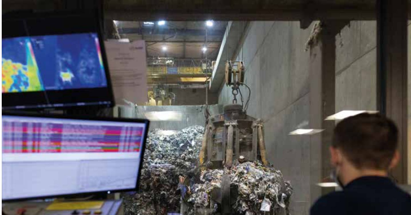
Usine CIE, Créteil
